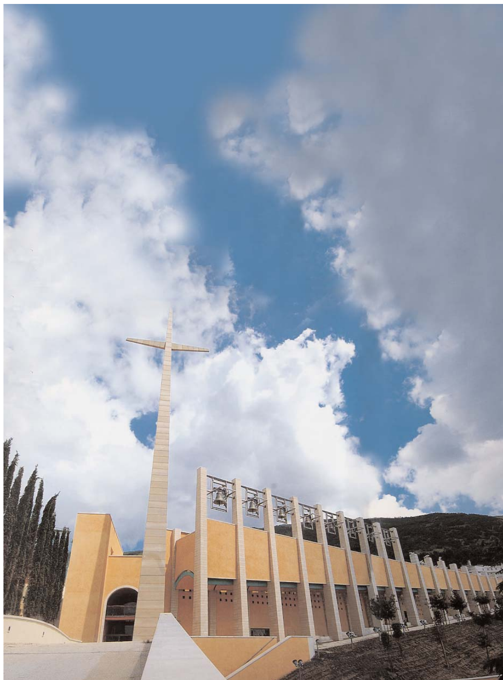
Die grosse mauer des durchgangs und des glockenwerks der „neuen kirche“.
